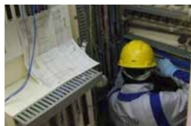
計装制御盤の交換
