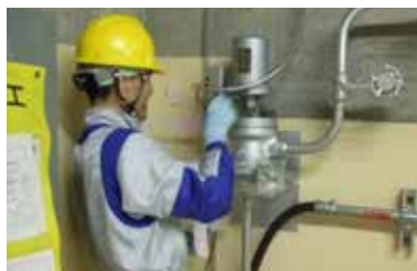
現場計器の点検
